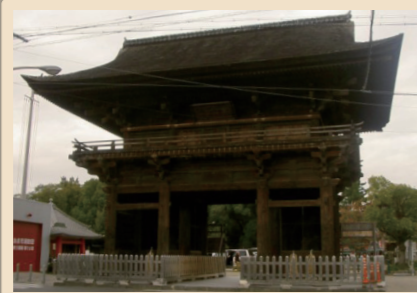
天正13年(1586)天正地震により本堂などが倒壊した記録が残る甚目寺(あま市)
