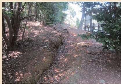
昭和20年(1945)三河地震で発生した宗徳寺の地割れ(蒲郡市)
