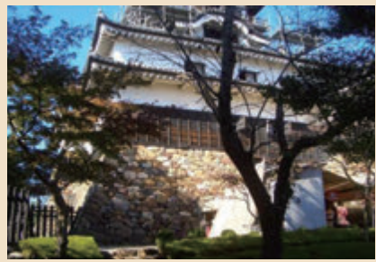
濃尾地震で石垣や天守閣の西半分が崩壊する被害を受けた犬山城(犬山市)
