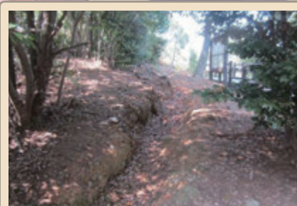
三河地震で発生した宗徳寺の地割れ(蒲郡市)
