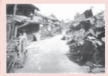
一宮市の被災状況 (「明治二十四年 濃尾大震災写真帖(復刻版)」(愛知県総務部消防防災課)より)
