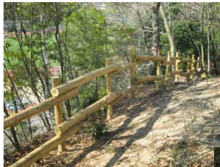
防護柵工の施工状況
