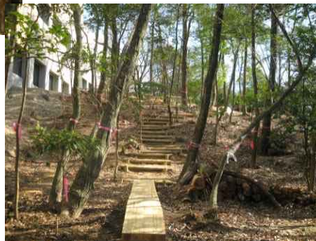
作業歩道の施工状況
