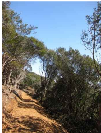
作業歩道の施工状況
