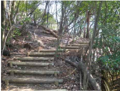
階段の施工状況
