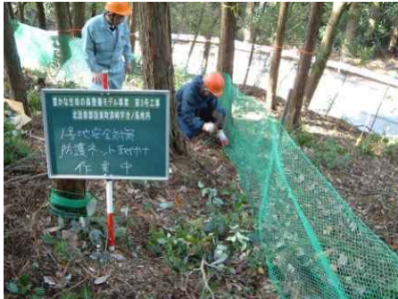
防護ネット設置
