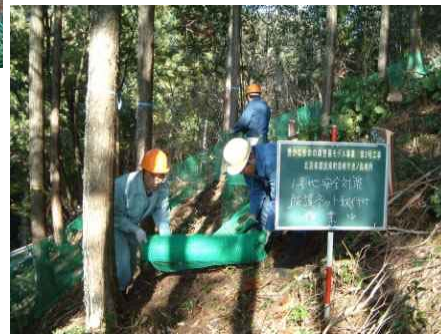
防護ネット取り付け
