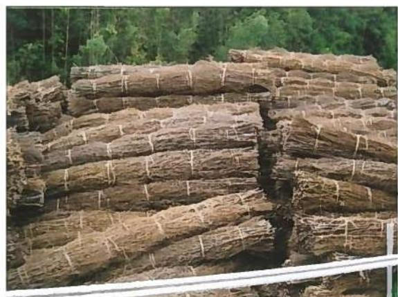
矢作川方式※において取り入れられた、沈砂池や竹の枝を束ねたもの（右写真）でろ過する濁水対策
