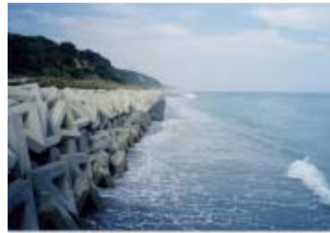
赤羽根漁港海岸高松の侵食状況(H13.12)
