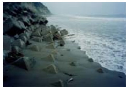
豊橋海岸西赤沢の侵食状況(H13.12)
