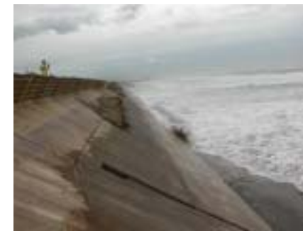
新居海岸の侵食状況(H14.8)
