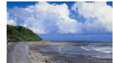
堤防（御前崎海岸）
