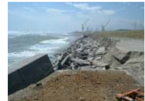
御前崎海岸の被災状況(H13.8)
