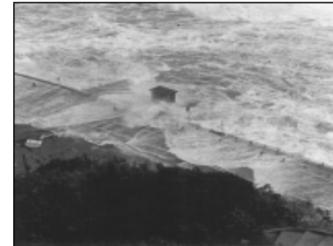
昭和 54 年の台風 20 号による 御前崎海岸の越波状況
