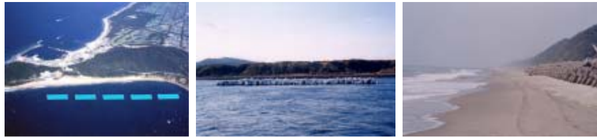
人工リーフ（渥美海岸〔恋路ヶ浜〕） 離岸堤（赤羽根漁港海岸〔若見〕） 消波堤（田原海岸〔大草〕）
