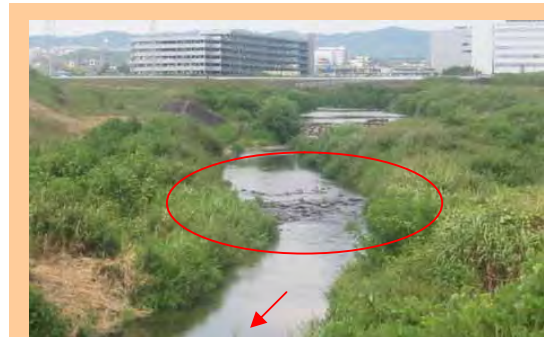
風景に馴染む多段式落差工(籠川)
