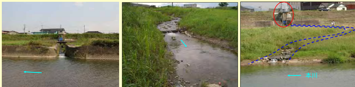
遠賀川 (左: 改修前、中・右: 改修後)(九州地方整備局)
