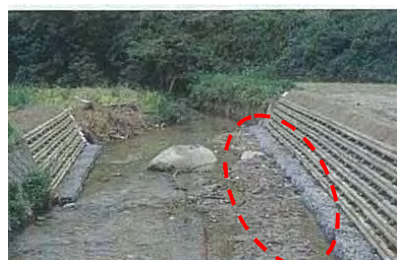
施工直後の寄せ土のイメージ
