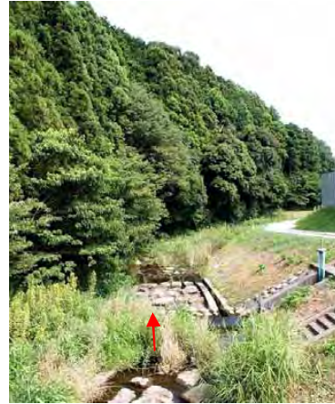
野田川 片岸に拡幅することによって山付部を保全したため、斜面林はそのままの姿で保たれ、水際部の改変も最小限で済んでいる。山付部には護岸や管理用通路を整備せず、コストダウンにもつながっている。
