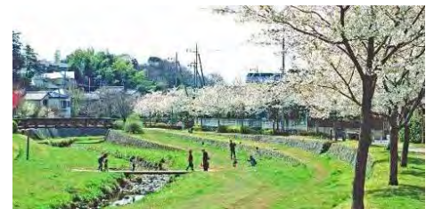
法面を小段で処理し、縦断方向にアクセス路を設置した例（和泉川・横浜市）
