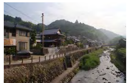
肌理の柔らかい自然石護岸(足助川)
