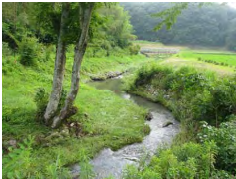
準用河川太田川 左岸側の樹木を保全するために法線を右岸側に蛇行させている。樹木の根本は、低い石積みで保護している。
