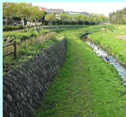
和泉川（横浜市）の天端処理の工夫 （写真提供：吉村伸一氏）
