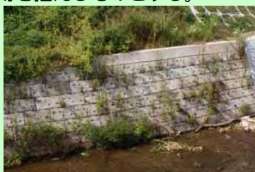
緑化ブロックの例(御津川)
