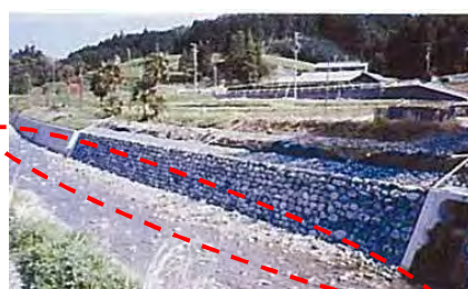
施工直後の寄せ石のイメージ
