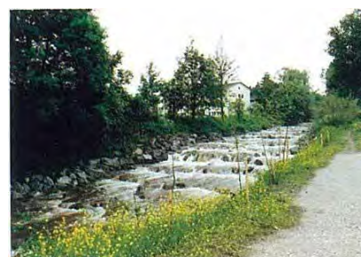
多段式落差工 (シュリーラッハ川・ドイツ) 取水のために高さ 4.5m の堰が設置されていたが、水利権消滅を契機に自然石を用いた階段状の落差工に改築された。
