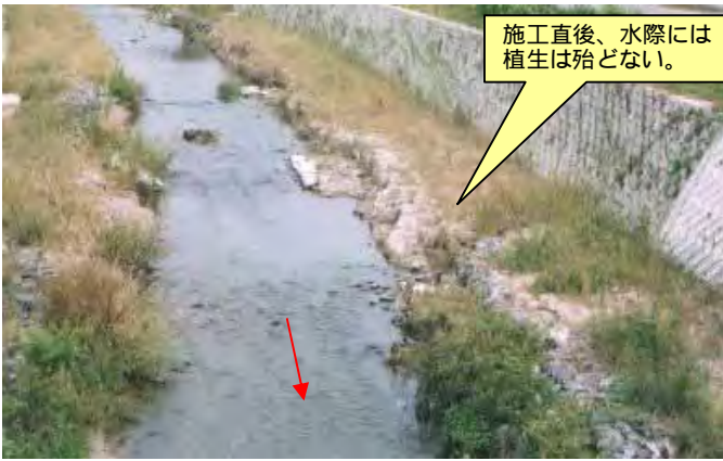
改修直後の河床状況
