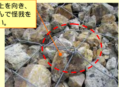
蛇籠の表面の状況
