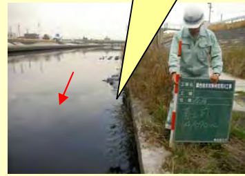
改修前の状況
