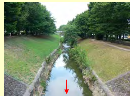
石積護岸（池合橋より上流部）
