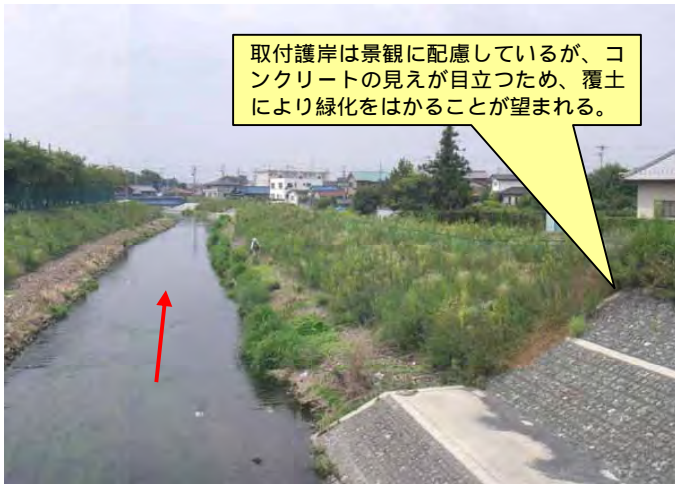
6/700 付近橋梁から下流
