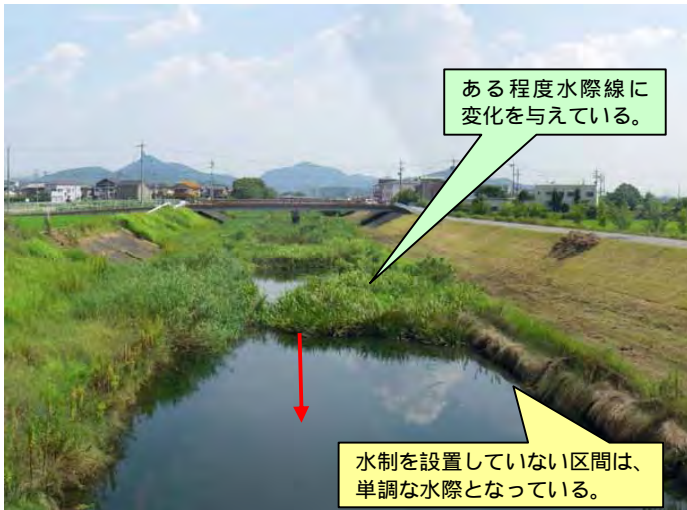
新塔野地橋から上流
