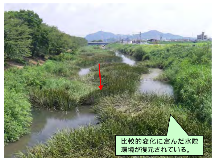
塔野地橋から上流（上流側の隣接区間）
