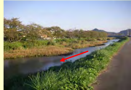
既往改修箇所（上流側の隣接区間）
