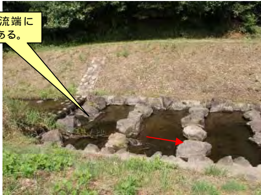
大洞橋から上流 湾曲部の落差
