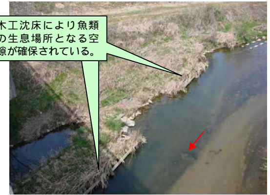
東梅坪橋上流の木工沈床
