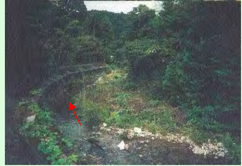
改修前の状況( 評価対象範囲より上流 ) 水裏部に砂州がつき、河床には瀬・淵があった。
