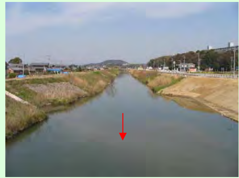
改修前の状況
