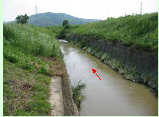
改修前の状況（下西野橋から下流）
