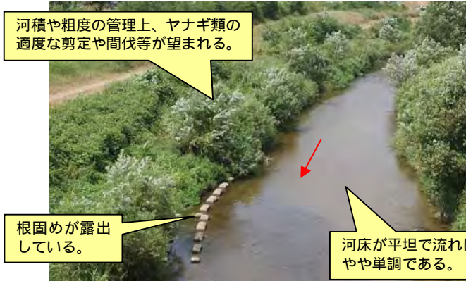
東梅坪橋上流の水衝部
