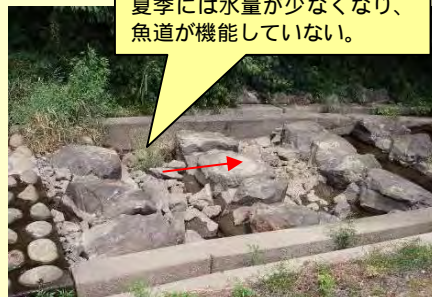
新吉橋の下流の落差工
