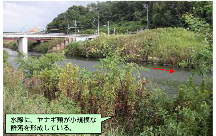
隣接区間(上流側) 右岸から上流
