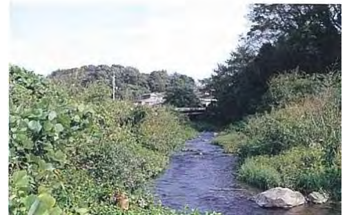
施工2年3ヶ月後
