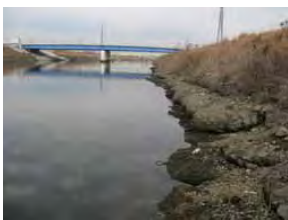
露出した袋詰め例
