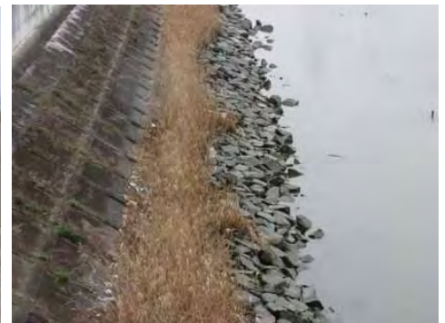
水際に捨石を設置した事例（逢妻川）
