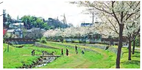
縦断方向の動線を形成するため法面を小段で処理した例（和泉川・横浜市）
