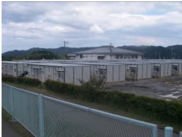
【避難所隣接仮設住宅】 避難所に隣接する空き地に続々と 仮設住宅が建設されている。
