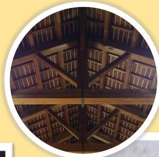
明治時代に弾薬庫として作られた乃木倉庫は、万が一の爆発の際には爆風が上方へ抜けるよう、壁が煉瓦造り、屋根小屋組みが木造になっています。
