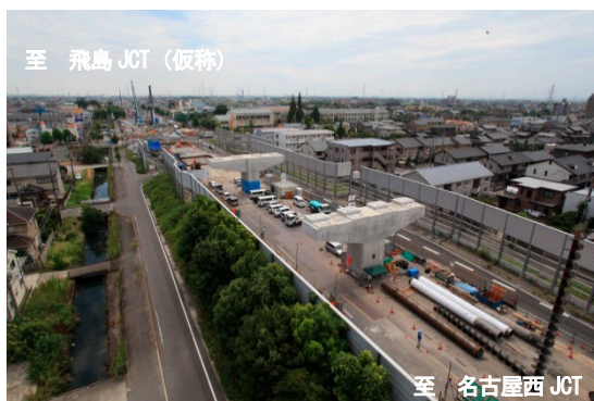
名古屋環状2号線 名古屋西JCT～飛島JCT（仮称） 西南部・南部区間：名古屋市港区（東海通付近）
