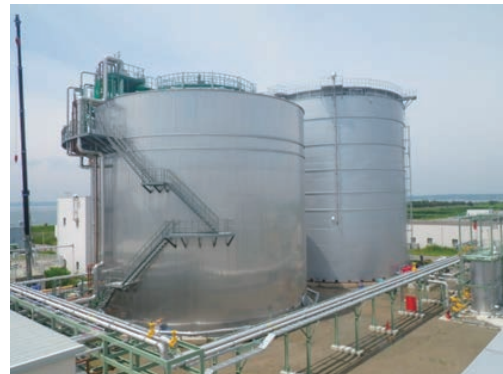
【下水汚泥メタン発酵施設（矢作川浄化センター）】
