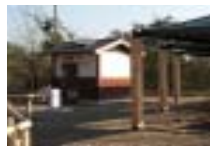
従来より改変面積が少ないピン杭工法。
