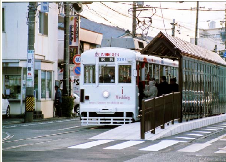
競輪場前電停安全島新設
