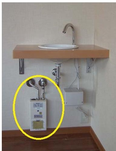
現在、販売に力を入れているのが、水と電気があればお湯がでる電気式瞬間給湯器「エマックス」。外部要因に左右されない経営基盤の確立を図るため、中部地区販売代理店となり、2009年から販売を開始した。「エマックス」本体はティッシュBOX程度の大きさで、重量は1.3Kgとコンパクトな設計。貯湯タンク、給排気設備等の付帯設備が不要なため省スペースで設置可能。水道水を直接電気で温めるので衛生的で、熱湯を出す機械ではないので、やけどの心配もない。医療・介護施設向けに営業活動を展開しており、異業種交流展示会メッセナゴヤ2012にも出展し、販路の拡大を目指している。
