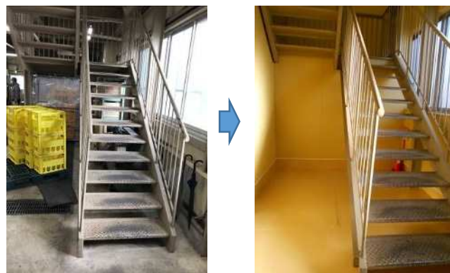
改修前／改修後
