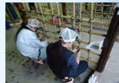
エクステリア実習 ブロック積みやレンガ敷き、垣根の施工技術を習得します。
