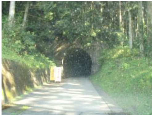
旧田口線第6トンネル
