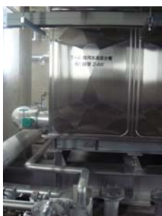
高架水槽（雑用水）
