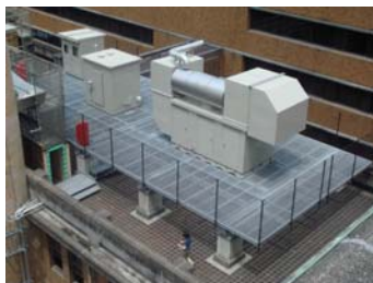
非常用発電機
