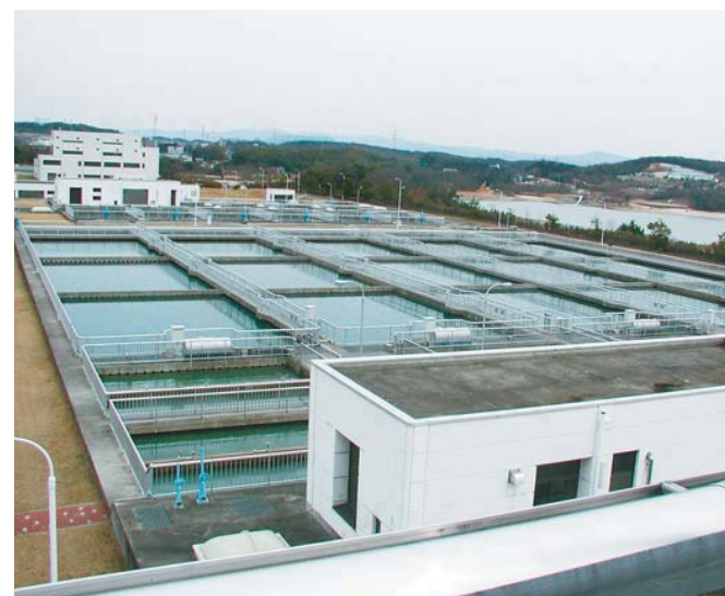
尾張東部浄水場
