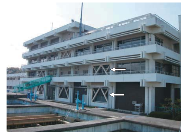
建物の耐震化事例（豊橋浄水場）
