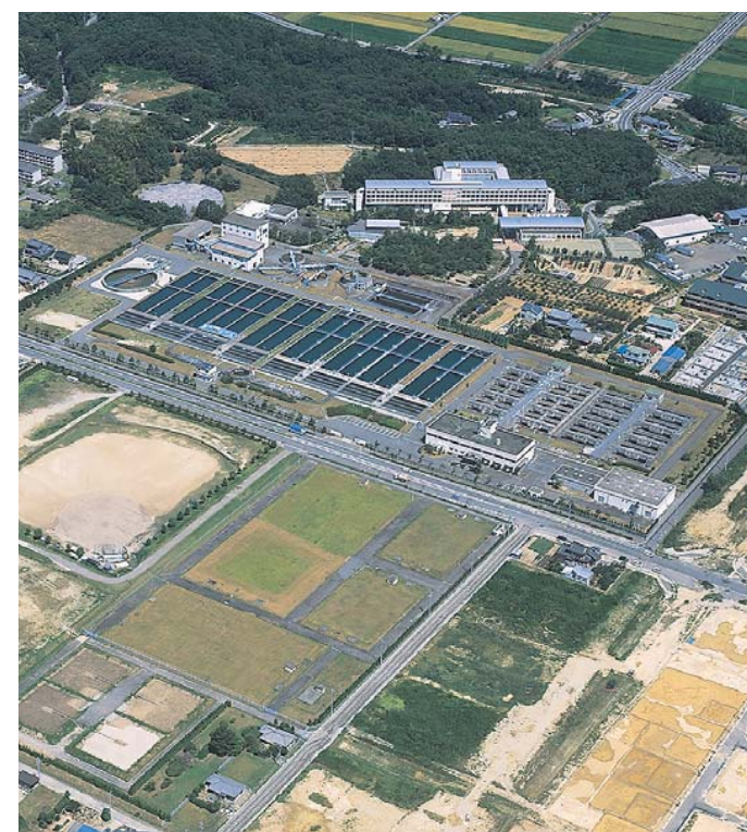
豊田浄水場（平成16年8月撮影）
