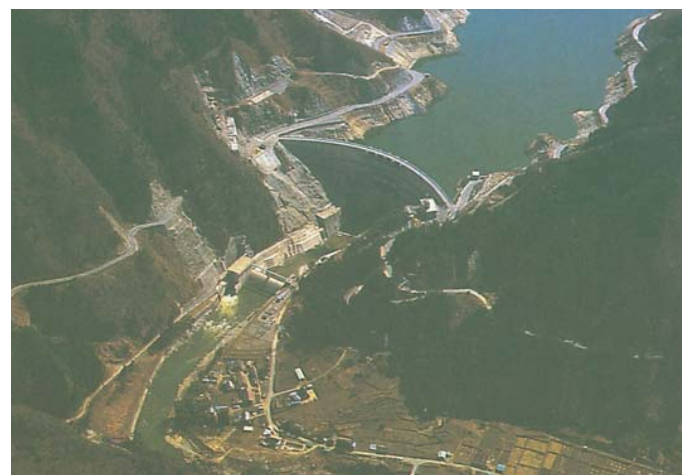
矢作ダム（平成12年11月撮影）
