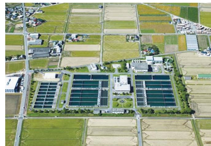
安城浄水場（平成24年10月撮影）
