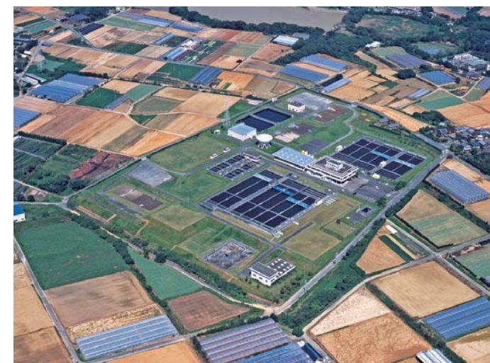
豊橋南部浄水場（平成18年9月撮影）
