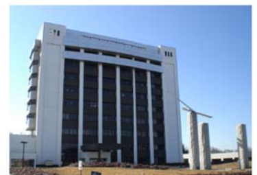
農業総合試験場本場 中央研究棟
