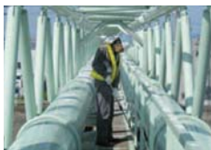
ガス設備の点検
