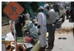
ガス導管復旧作業 (東日本大震災: 仙台復旧時)
