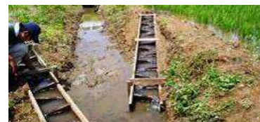
水田魚道の設置
