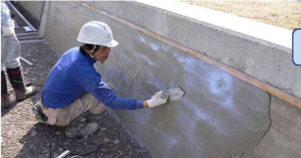
老朽化した水路壁のコーティング
