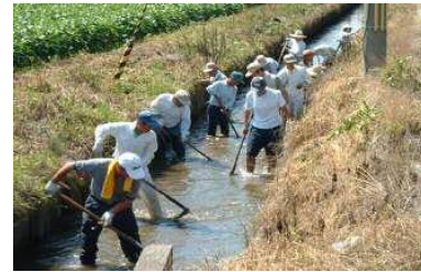
水路の泥上げ
