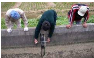
施設の機能診断
