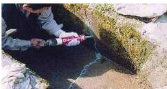
水路のひび割れ補修
