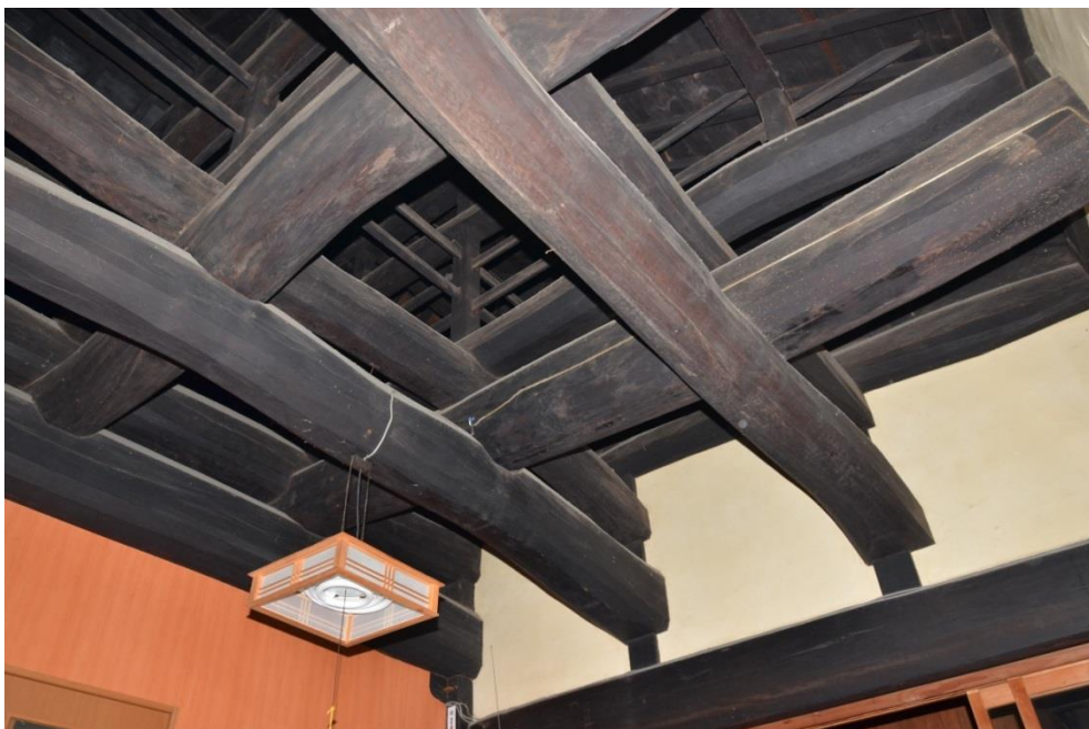
颯田家住宅主屋 広間（ダイドコロとオカッテ）の小屋組（西尾市教育委員会提供）
