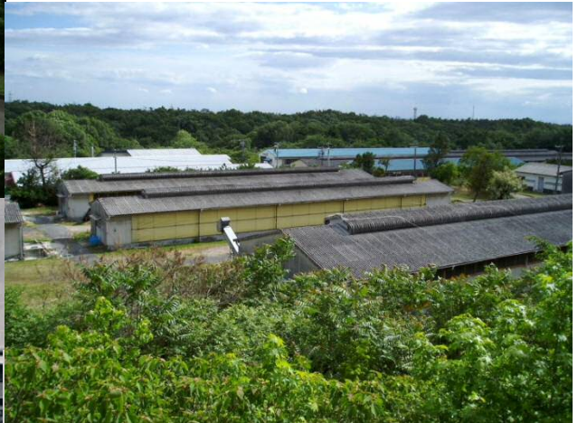
鶏舎群 (上 : 現在、下 : 創設当時)
