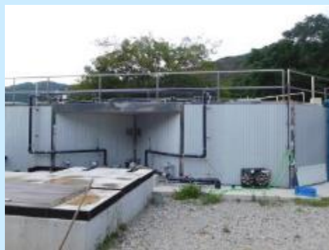
メタン発酵施設
