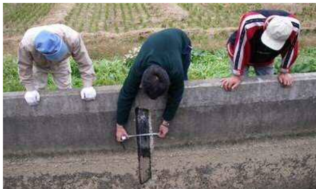
施設の機能診断
