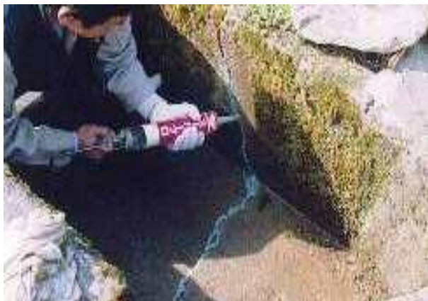
水路のひび割れ補修
