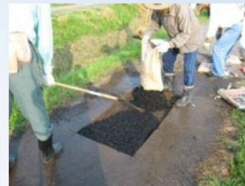
農道の部分補修
