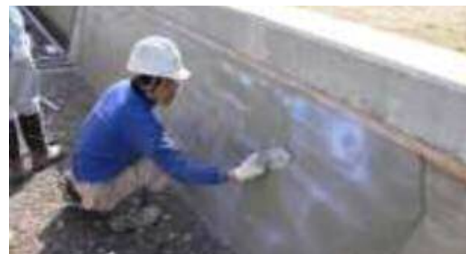
老朽化した水路壁のコーティング
