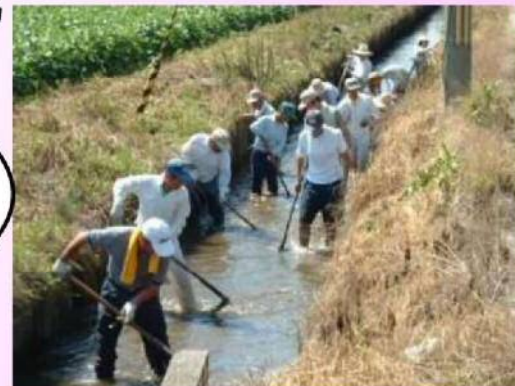
水路の泥上げ
