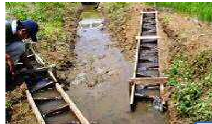
水田魚道の設置
