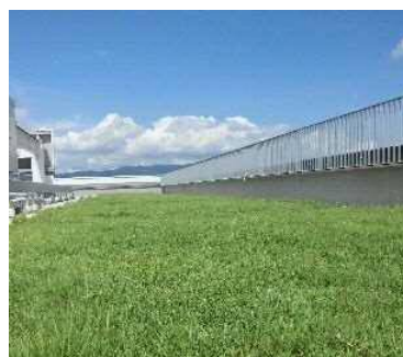
公共施設の屋上緑化（愛西市）
