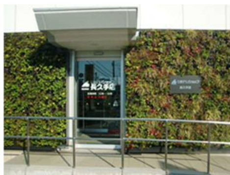
壁面緑化（長久手市）
