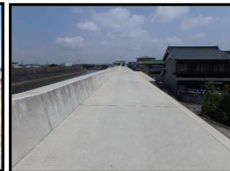
一色漁港海岸(西尾市)
