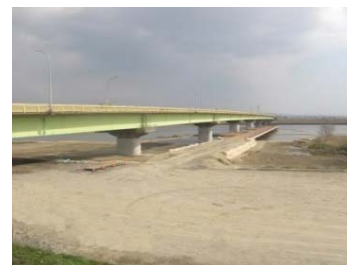
(主)岡崎碧南線・棚尾橋(碧南市)
