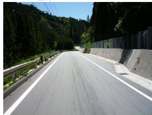
山間地域の1.5車線の道路整備事例 ((一)振草三河川合停車場線(待避所設置)) 【整備後】
