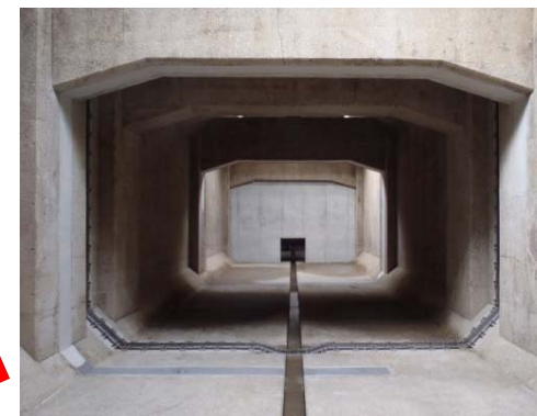
境川流域下水道 水処理施設(EXP.J設置) (刈谷市)
