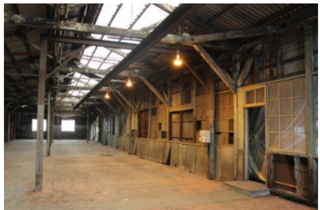
愛知製鋼刈谷工場旧試作工場西棟 (旧豊田自動織機製作所自動車部試作工場) 内部 (東から西を望む) (刈谷市教育委員会提供)
