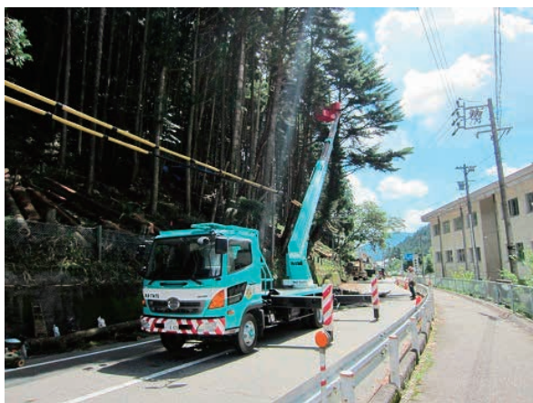
高所作業車による作業
