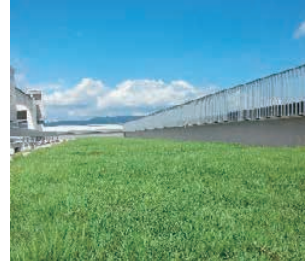
公共施設の屋上緑化（愛西市）
