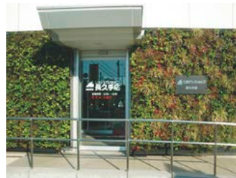
壁面緑化（長久手市）
