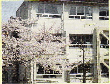
4月 耐震工事も終了しました
