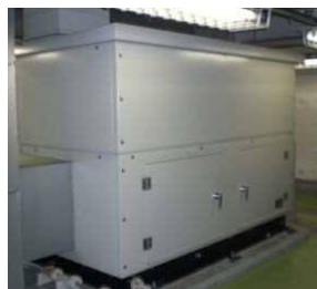
非常用発電機
