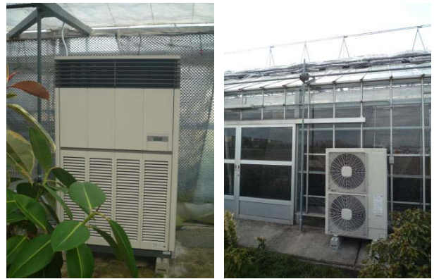
観葉温室に導入したヒートポンプの室内機(左側)、室外機(右側)
