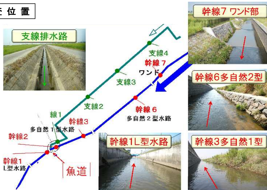
H19～20 に改修前、H21～25 に改修後の定点調査を実施した
