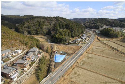
南川遺跡の全体写真です
