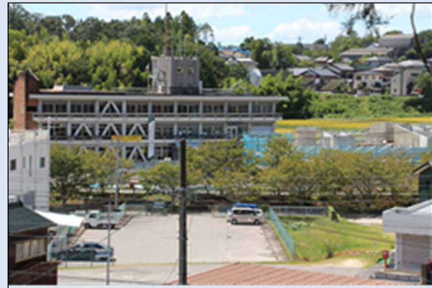
整備後 (施行中)
