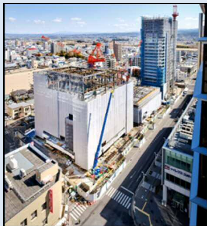
整備後 (施行中)
