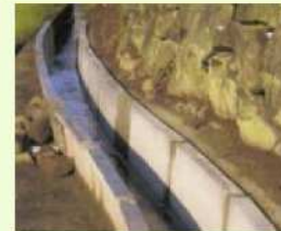
コンクリート水路の更新
