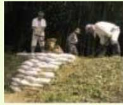
漏水箇所の補修
