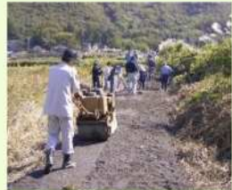
未舗装農道の舗装
