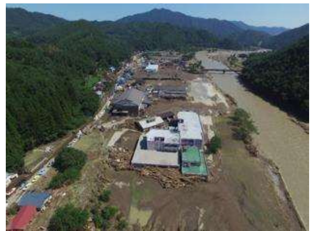
▲社会福祉施設等の被災状況（岩手県岩泉町） （写真）中部地方整備局
