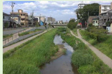
多自然川づくり (矢作川系伊賀川:岡崎市)
