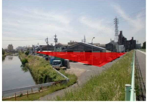
⑨地蔵川：排水機場予定地（用補及び工事）
