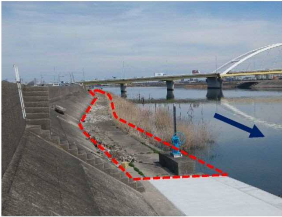
①新川：堤防耐震化工事
