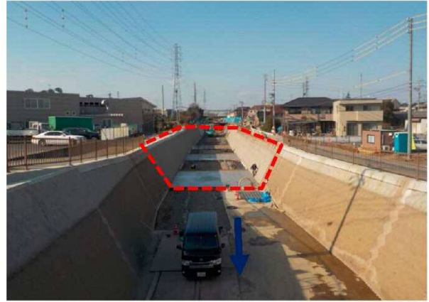
⑩薬師川：護岸工事
