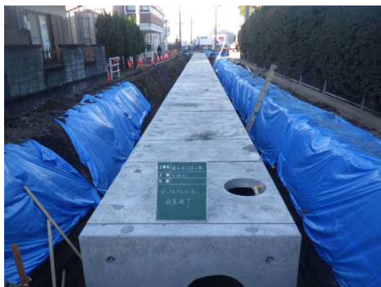
新宮雨水貯留施設 (約 150m 3 : 大口町)
