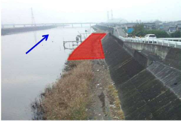
①新川：堤防耐震化工事
