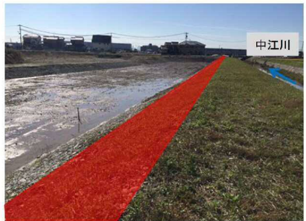
④中江川：調整池護岸工
