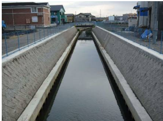
準用河川千間堀川改修（一宮市）
