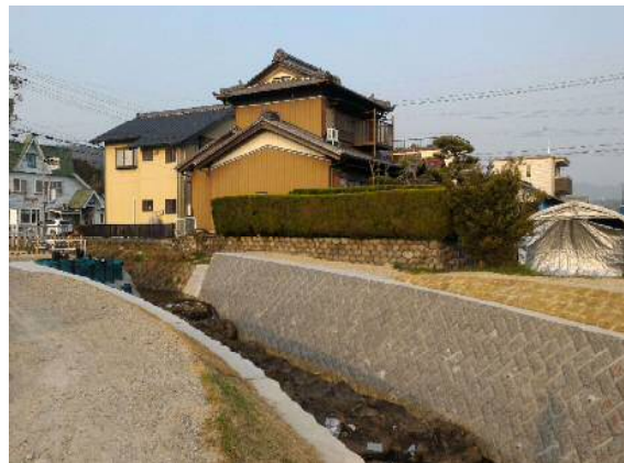
準用河川道木川改修（小牧市）
