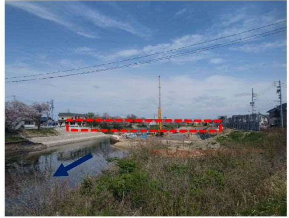
②五条川：船杓橋改築工事
