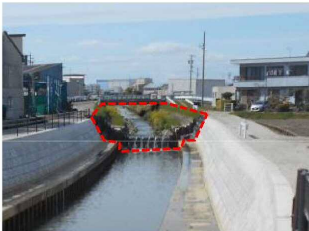
③水場川：護岸工事（西流橋付近）
