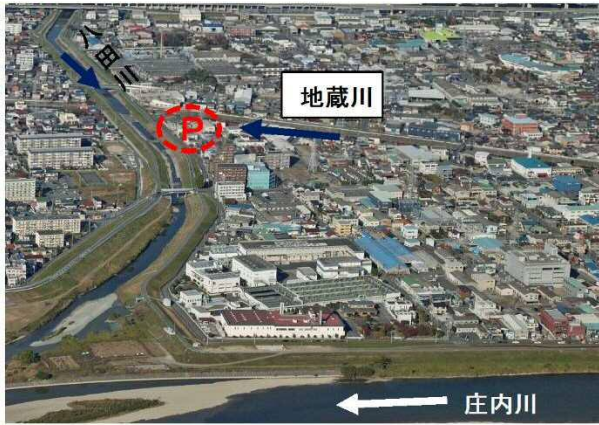
⑨地蔵川：排水機場建設予定箇所
