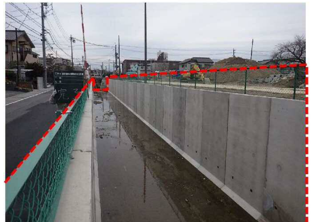
⑤原川：護岸工事（小牧高校付近）
