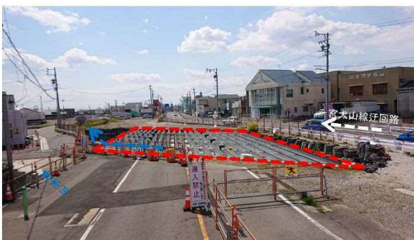
⑥青木川：県道一宮犬山線橋梁改築
