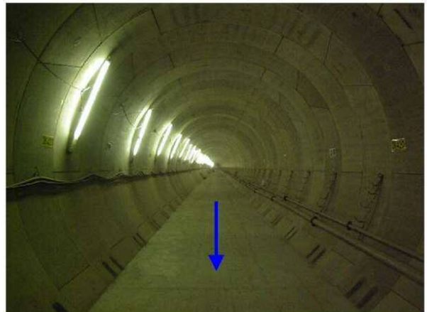
⑦青木川放水路施工中
