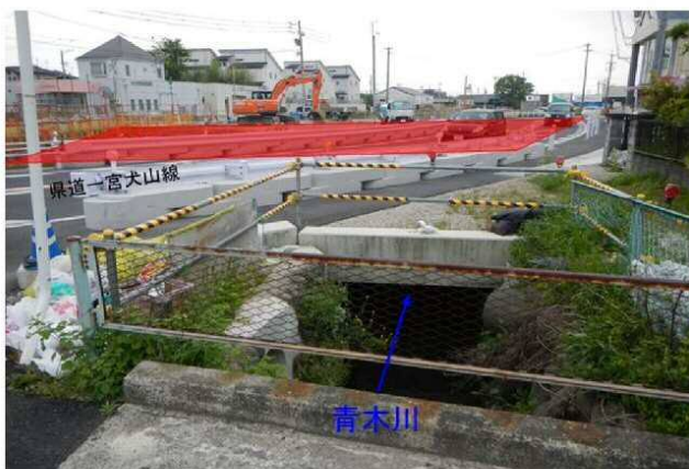
⑥青木川：県道一宮犬山線橋梁改築
