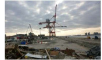
②クローラークレーン等による荷役再開(H23.6)
