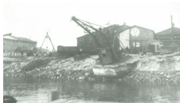
昭和19年12月 昭和東南海地震 地震で倒壊した係留施設(名古屋港東埠頭)
